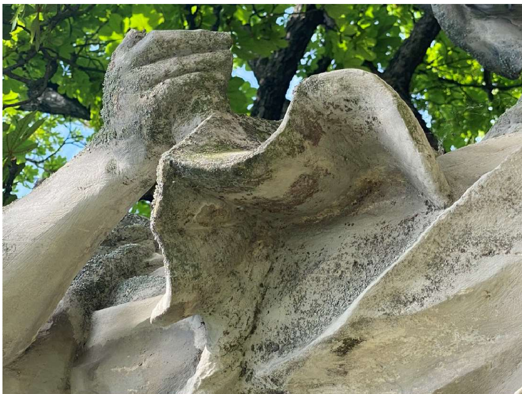
Detail draperie: béžový nátěr, nanesený v silné vrstvě, pod kterou kámen degraduje
