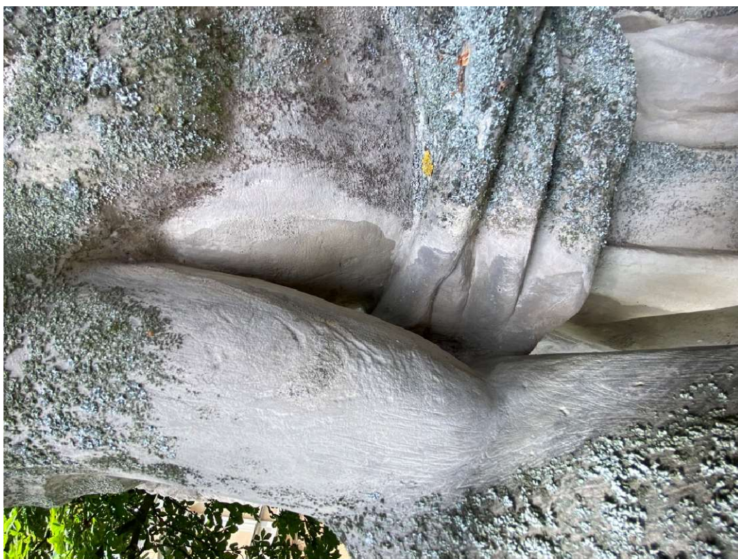
detail - silné biocidní napadení, výskyt sádrovcových krust
