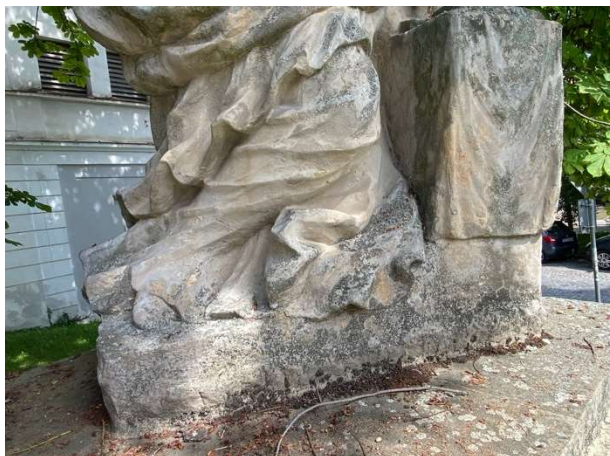
biologické napadení, mechy lišejníky – často na vlhkých místech
