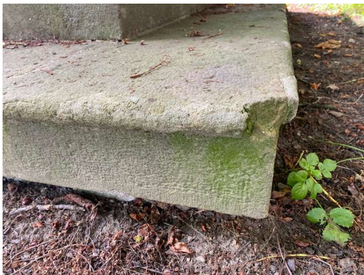
Mechanické poškození
