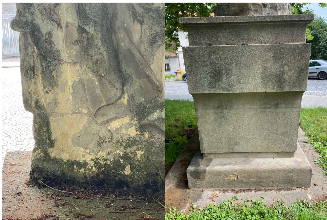
Koroze kamene – pod silným nátěrem – úbytek originální hmoty
