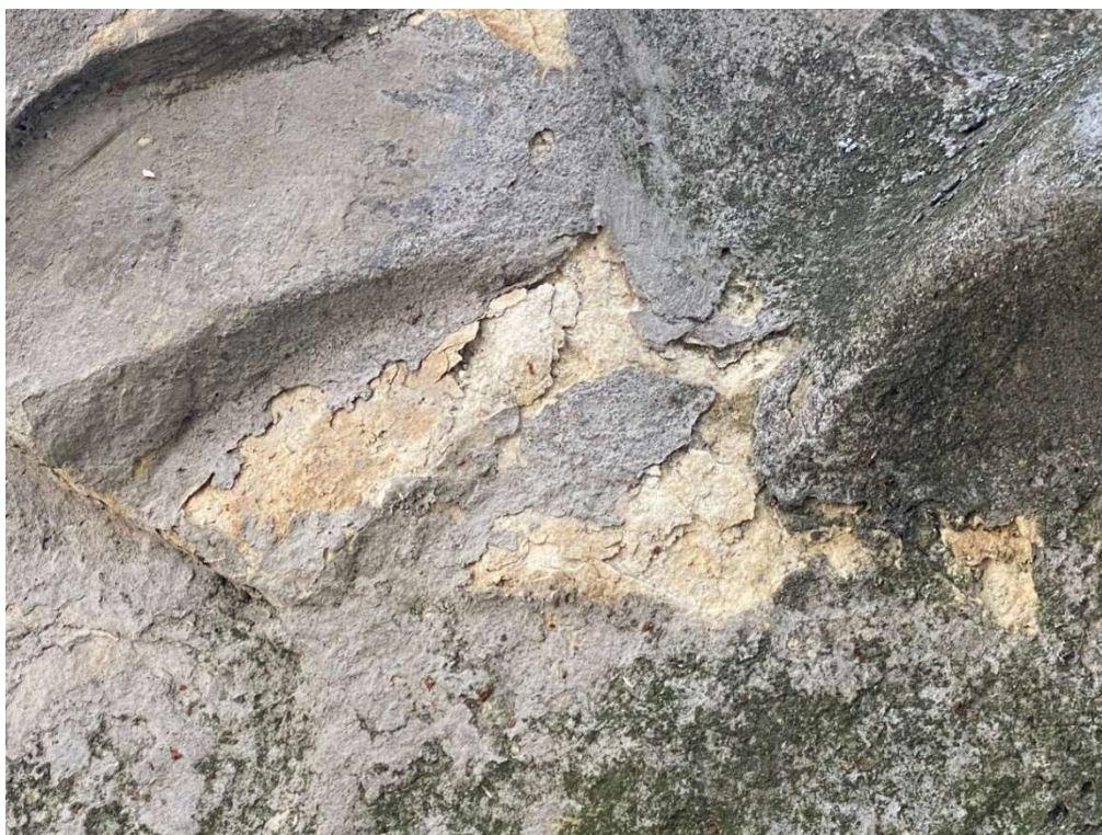
Degradace kamene pod nátěrem
